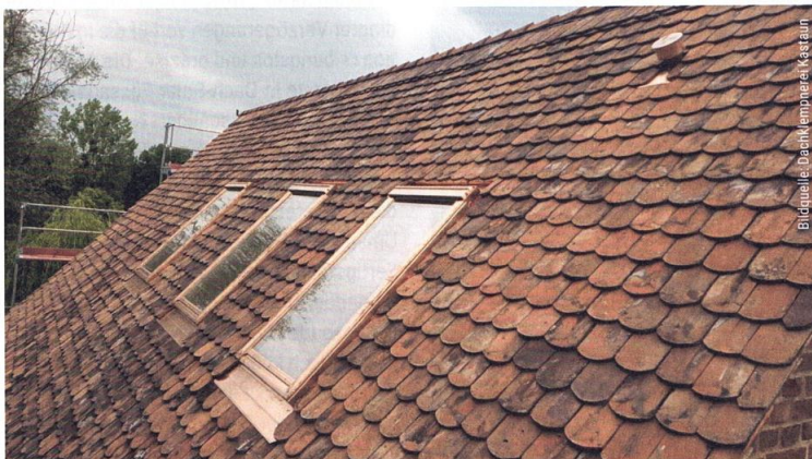
Mit den Gewerken Spengler, Dachdecker und demnächst noch Zimmerer hat die Firma Kastaun auch digital alle Schnittstellen im Griff.
